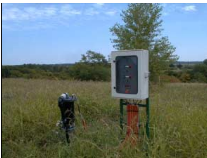
PHOTOGRAPHIE 9 : PUIITS EN PLACE
