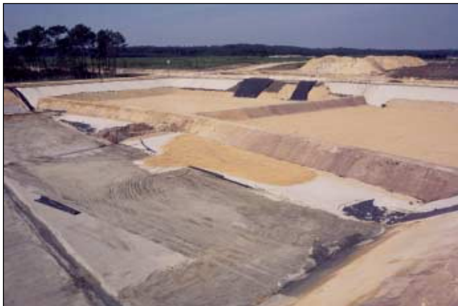
PHOTOGRAPHIE 3 : SUBDIVISION D'UN CASIER EN ALVEOLES
