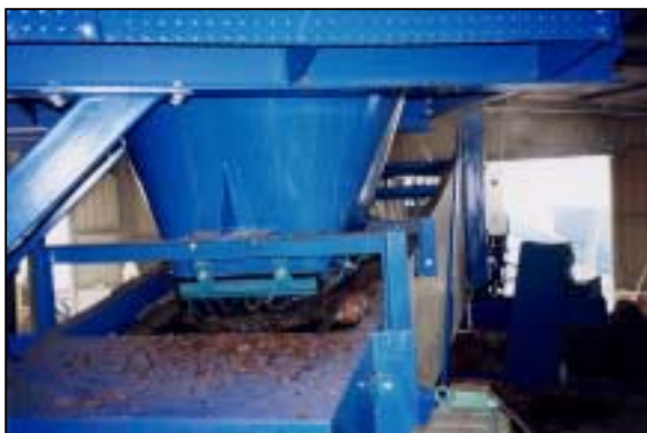
Mélange boues et support carboné sur tapis d'amenée aux alvéoles pour fermentation
