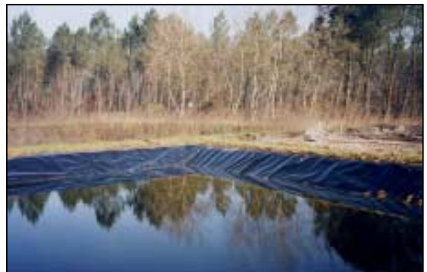
Bassin de rétention des jus issus du compostage (réinjectés ou traités avant tout rejet dans le milieu naturel)
