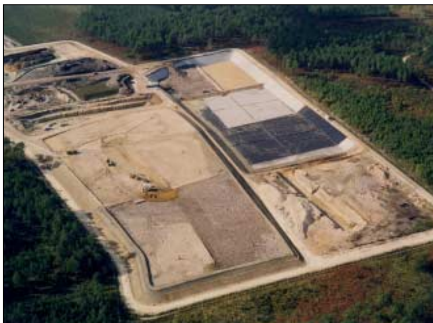
Photographie 1 : vue aérienne d'un centre de stockage en cours d'exploitation
